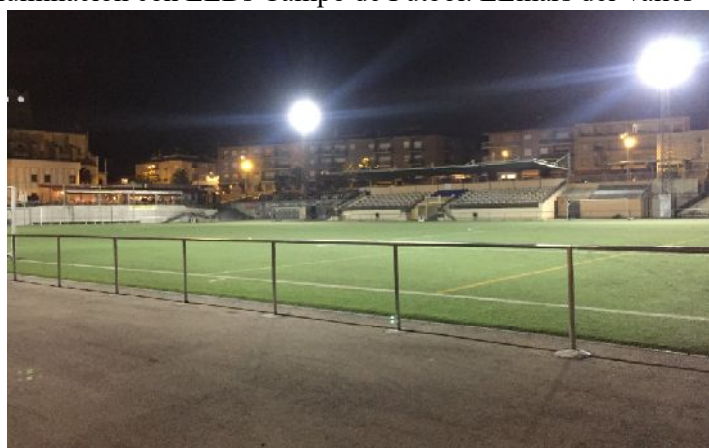
Cambio de luminaris de 2x400 por luminaris de 400 w LED regulables desde pie columnas. Total 24 ptos
